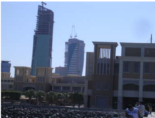
クエート市内の建設中のビル
